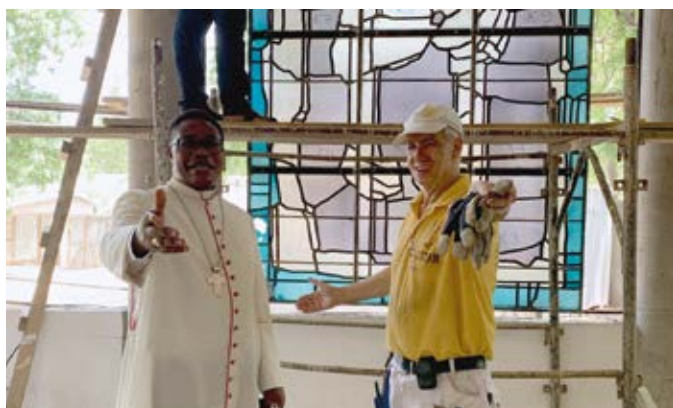
Bischof Bruno Ateba freut sich über den Baufortschritt in der neuen Kathedrale für Kameruns Norden.
